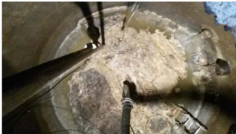
Abbildung 5: Blick von oben auf die Schwimmschicht einer Pumpstation in Mürzzuschlag
